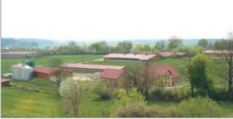
Installaties voor uw erf
