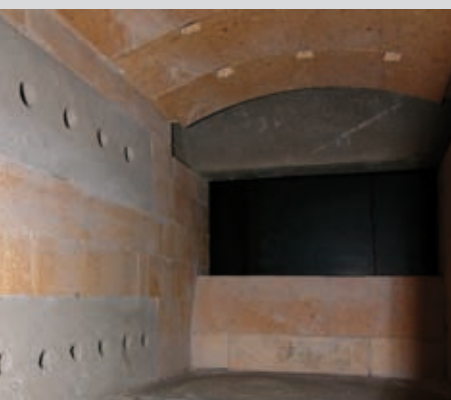
Verbrandingskamer volledig met chamotte bekleed.
