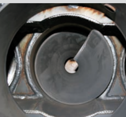
Wervelvizels om de rookkanalen te reinigen.
