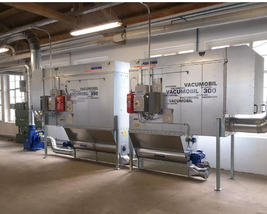
Zwei Vacumobil JZ 350 Entstauber in Außenaufstellung. Die gefilterte Luft wird in die Produktion zurückgeführt und die Wärmeenergie bleibt erhalten.
